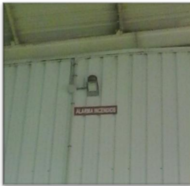
Alarma visual incendio
