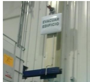
Paneles luminosos evacuación de fábrica
