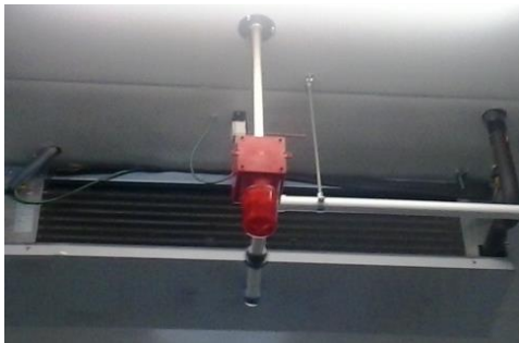
Baliza luminosa de peligro en zonas de paso de carretillas
