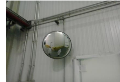
Espejos en puntos de baja visibilidad y de circulación de maquinaria
